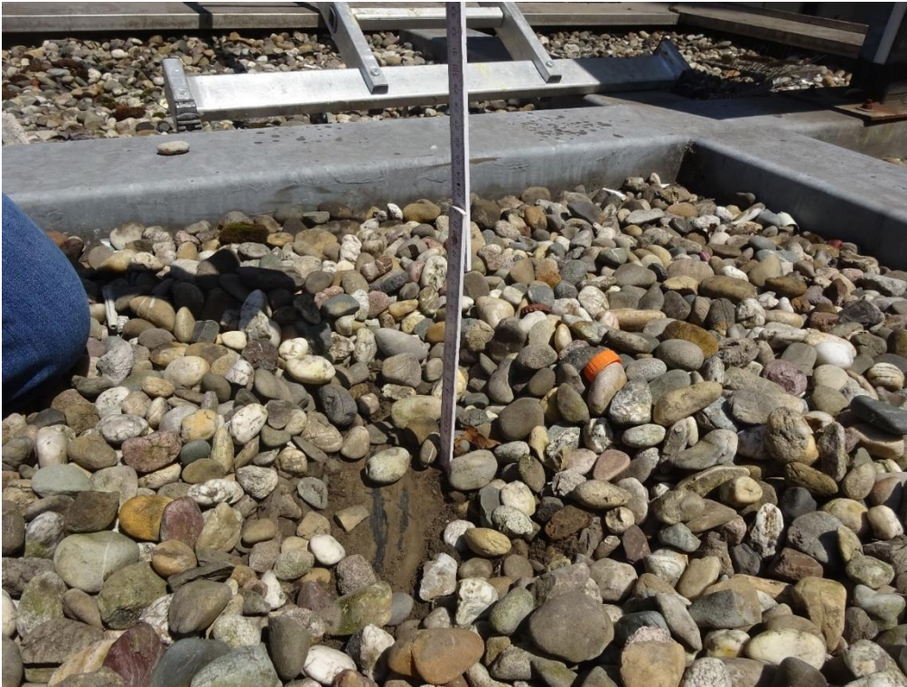
Bild5: Dachaufbau mit Kiesschicht
