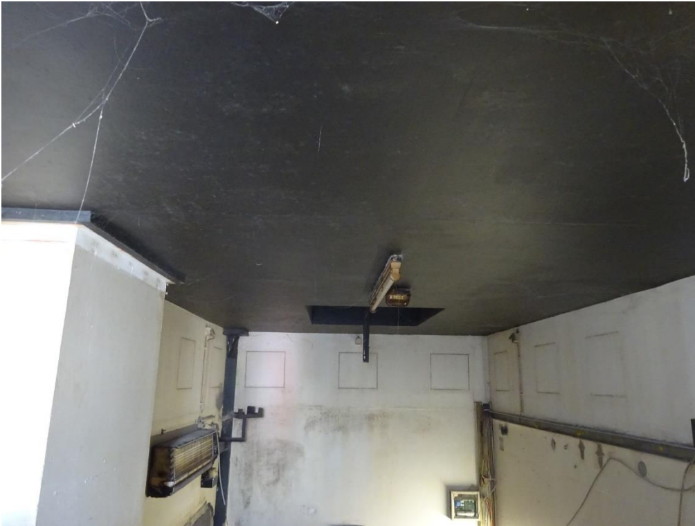
Bild 3: Untersicht Decke mit Abhangdecke
